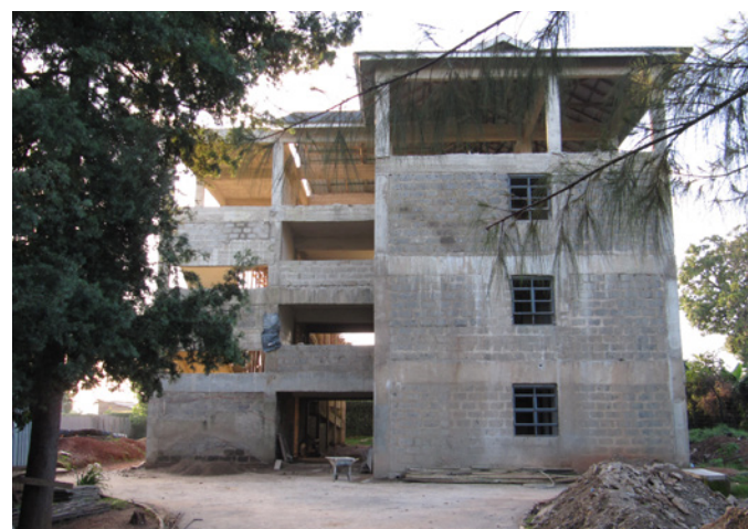
De kinderafdeling in aanbouw.
